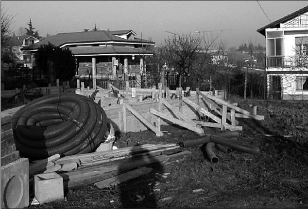
La base di cemento dell'antenna in costruzione.
