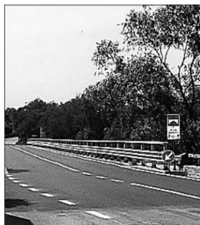
In questo modo la carreggiata è passata dalla larghezza di metri 6,70 a 7 equivalente a due corsie di 3 metri ciascuna ed una banchina transitabile di 0,50 per senso di marcia.
