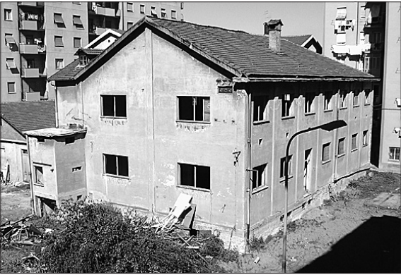
L'ex fabbrica "Torelli" in demolizione.
