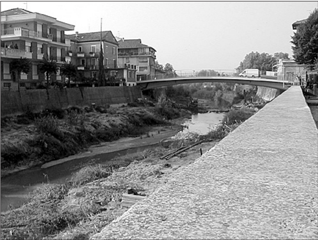
Minoranza all'attacco dell'amministrazione per il nuovo ponte sul Belbo
