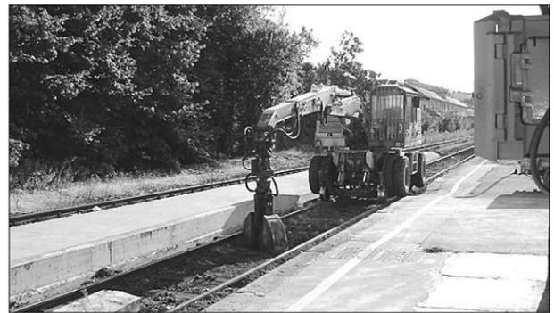
**Canelli.** È con soddisfazione che abbiamo fotografato i lavori in corso alla stazione ferroviaria di Canelli. È infatti in stato avanzato la costruzione di una nuova pensilina di un centinaio di metri, in cemento, più alta della preesistente, tra il primo e il secondo binario, che permetterà una più comoda e sicura salita e discesa ai vagoni.
