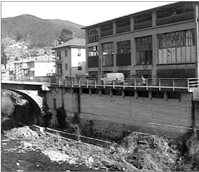
L'area ex Cerusa (area "Frera") a Masone.
