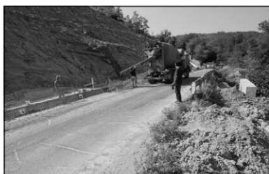
nufatto a gradoni la costruzione di un muretto in cemento armato, dell'altezza media di 1,25 metri, proteggerà il piano viabile. A circa metà del fronte frana, sotto la strada, sarà, invece, realizzato un attraversamento idraulico costituito da un tubo in calcestruzzo, con una cunetta alla francese senza cordolo sul lato monte e il rifacimento del casonetto stradale.
