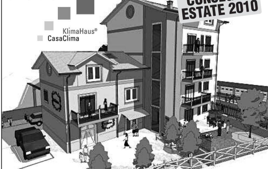
L'edificio avrà un fabbisogno di calore per il riscaldamento specifico pari a 35 kWh/mq anno. Si consideri, per puro paragone, che lo standard costruttivo attuale è di 80/120 kWh/mq anno, mentre la media dei fabbricati esistenti è pari all'incirca a 200 kWh/mq anno.
