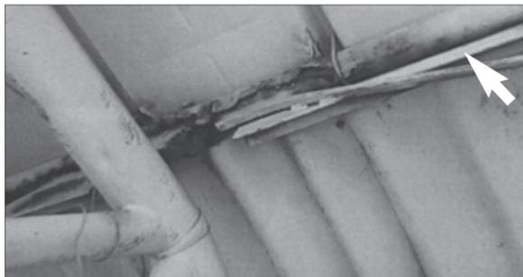
Il dettaglio della parte terminale della trave secondaria di supporto delle lamiere grecate di copertura, al contatto con gli elementi terminali curvi (lato monte) in fibrocemento. Anche qui la corrosione ha irrimediabilmente compromesso la stabilità dell'elemento (si osservi il profilato di rinforzo, indicato dalla freccia, già posizionato in passato).
