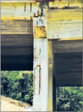
▲ Autostrada A6, corsia Nord, viadotto di Ferrania, Comune di Cairo Montenotte-SV
