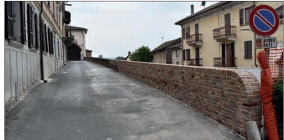
facimento “a piombo” utilizzando gli stessi mattoni originali precedentemente prelevati e avendo cura di sostituire quelli deteriorati con altri analoghi per caratteristiche agli esistenti, e a loro volta recuperati da altre demolizioni, un intervento di pulizia e scrostamento dell'intonaco non compatibile con il paramento di mattoni esistenti.
