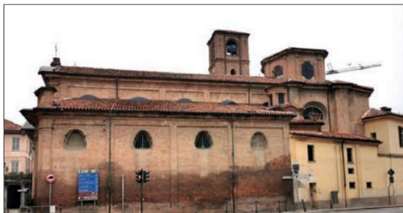
nel restauro completo del tetto. Conservazione della grossa orditura, sostituzione completa della piccola orditura. Restauro delle cupole nella seconda parte delle dei lavori.
