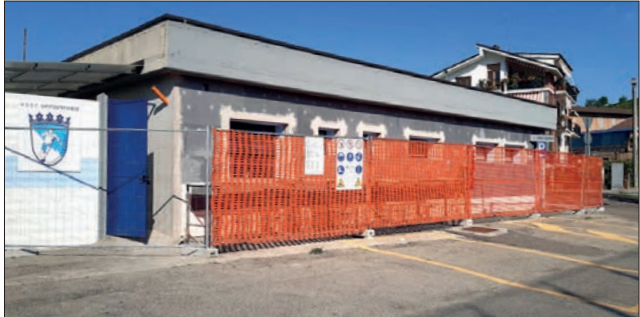
▲ I lavori per il cappotto termico degli spogliatoi
