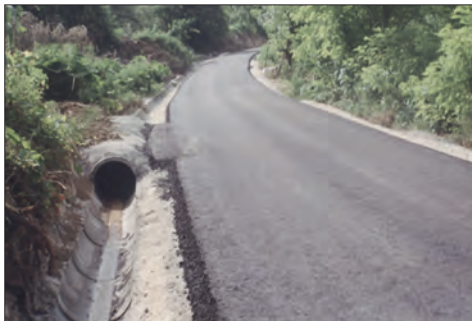
▲ 1994, sistemazione di strada Bracco
