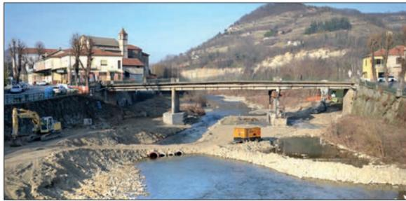
questi ultimi anni, rappresentavano un intralcio in caso di piena e favorivano la formazione dei vortici di erosione del terreno intorno alle fondamenta del ponte. Dopo aver puntellato il ponte per sostenere l'impalcato ed evitare anche minimi cedimenti, si sta ora procedendo a consolidare le pile con iniezioni di cemento. Il cantiere va avanti con la realizzazione di un sistema di protezione dell'erosione del terreno con nuove soffondazioni delle pile costituite da 38 mediopali armati
