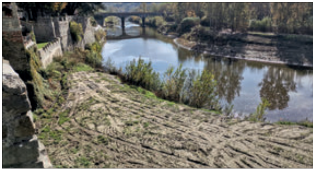
▲ Risagomatura alveo fiume Bormida
