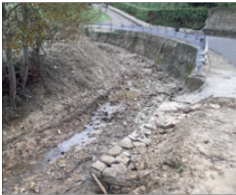
▲ Muro di sponda sulla strada per Montabone
