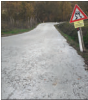
▲ Ripristino strada "Borrella"
