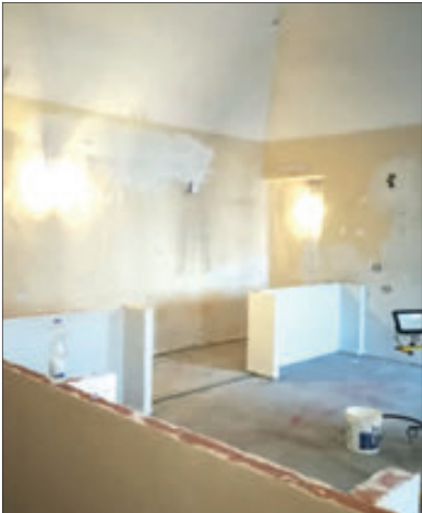
▲ Lavori in Curia
