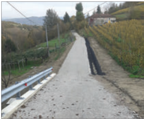
▲ Consolidamento di strada Gaiasco
